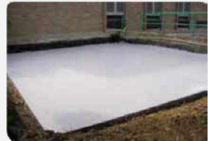
Techo de concreto con recubrimiento Floor-Flex
