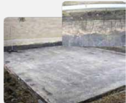
Techo de concreto antes de aplicación de Floor-Flex
